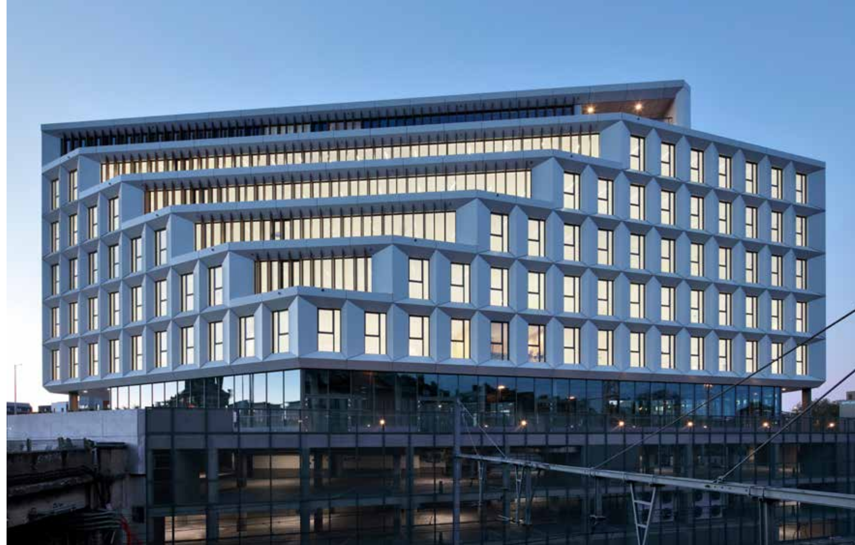
Ce chantier d'envergure a mobilisé de nombreux sous-traitants, mais Thomas & Piron Bâtiment a pu compter sur ses propres équipes pour les installations techniques.
