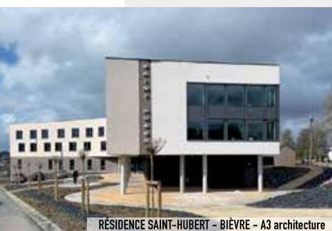
RÉSIDENCE SAINT-HUBERT - BIÈVRE - A3 architecture
