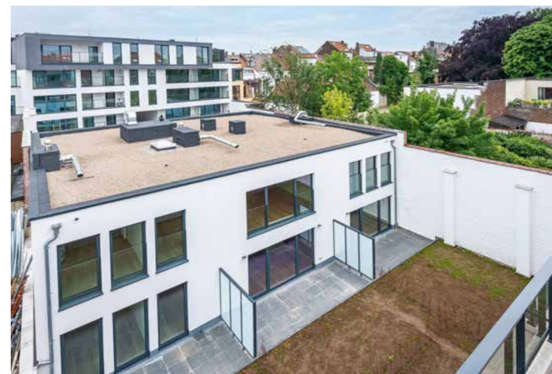
Les fenêtres ont été conçues selon la proportion particulière du nombre d'or, ce qui correspond aux fenêtres classiques des habitations bruxelloises anciennes.
