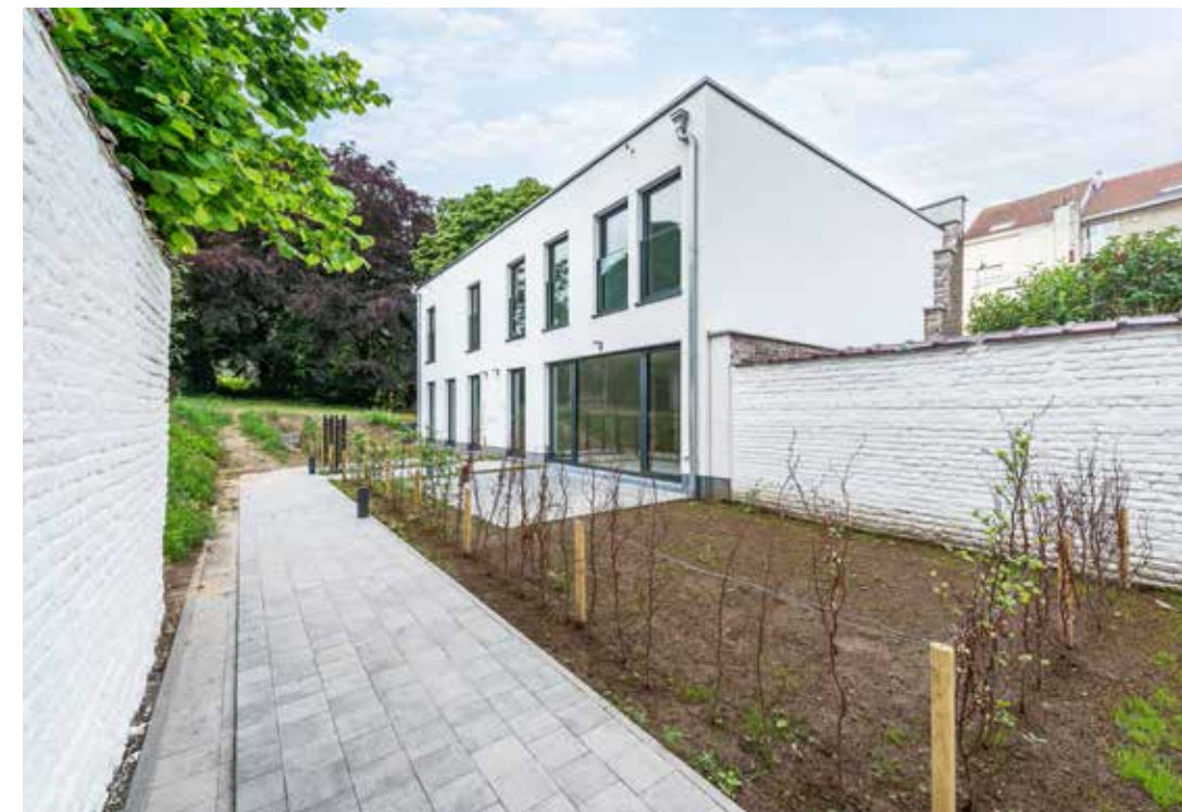
Une des originalités du projet réside dans l'existence, au sein des immeubles à appartements, de deux maisons mitoyennes basses.
